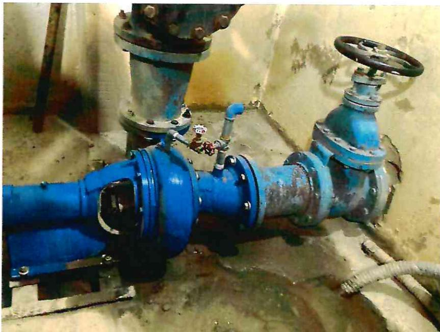
Se evidencia en la visita que hay rastros de fugas de agua en la tubería de impulsión de la bomba #2.
