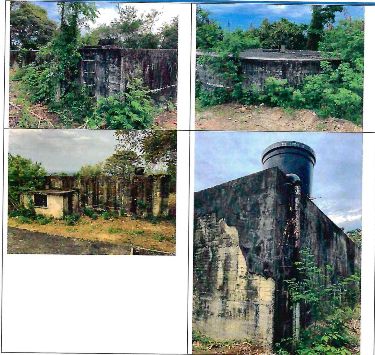
En la visita se ha podido comprobar el estado precario a nivel estructural de los tanques, además de falta de mantenimiento en las válvulas de control y regulación de los tanques.
