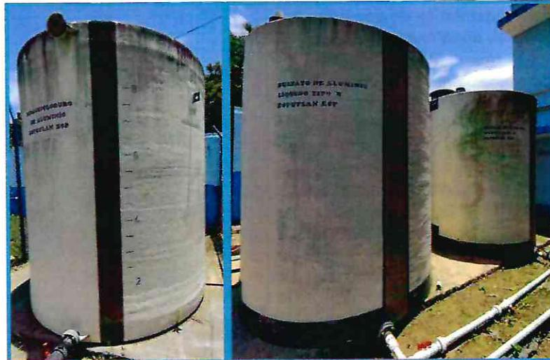
Tanques de almacenamiento de coagulante líquido con capacidad para 10.000 litros, fabricados en fibra de vidrio y con man-hole en la parte superior.
