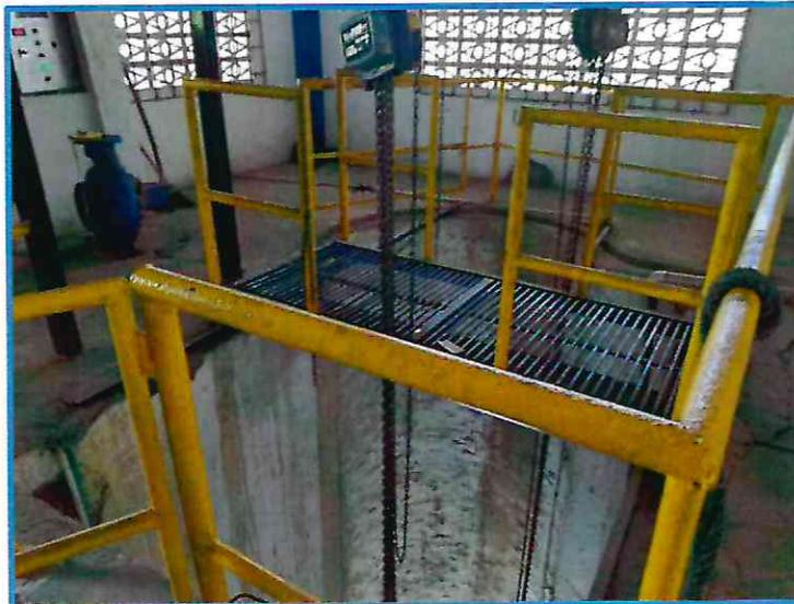
En la caseta #1, una estructura con dos (2) diferenciales para realizar la extracción de los equipos para mantenimientos preventivos y correctivos a los conjuntos motor-bomba #1 y #4 de agua cruda.
