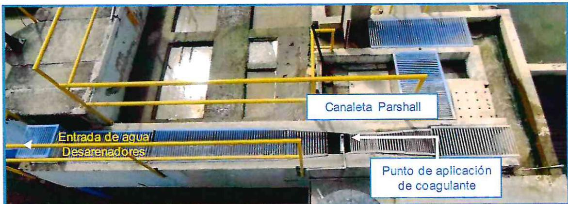
Canaleta Parshall – se observa la entrada de agua cruda y dosificación del coagulante según resultado de jarras.
