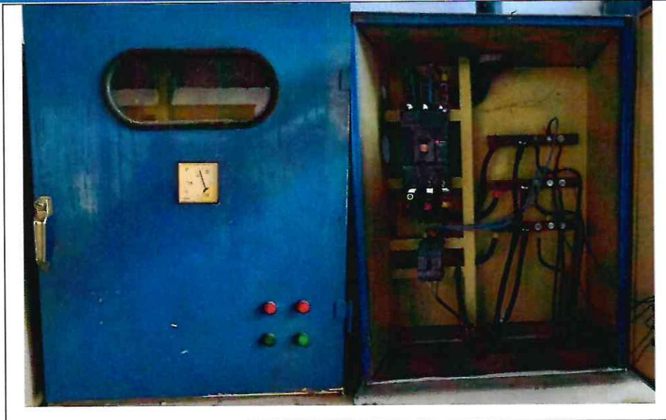
Cada circuito de mando tiene 3 contactores, una protección llamada bimetálico, el cual protege el motor. Tiene indicadores pilotos: el verde significa que el motor está energizado es decir en operación, y cuando marca rojo es para indicar alguna sobrecarga en el motor el cuál es accionado por el bimetálico (en este caso es la protección del motor).
