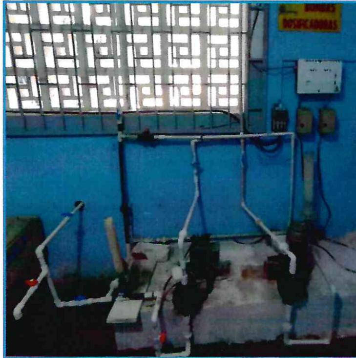
**Bombas dosificadoras de coagulante** tipo diafragma de 90 L/h, y operan según el tanque de almacenamiento con el que se esté trabajando.
