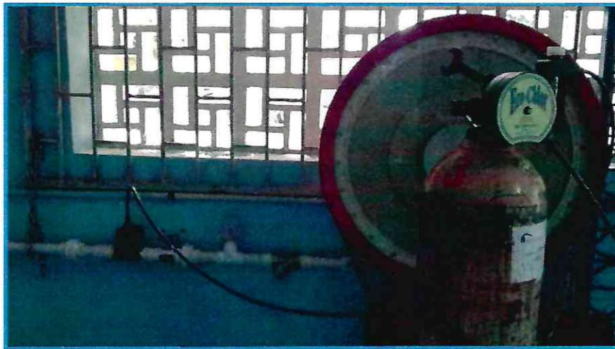
La desinfección se realiza con cloro gaseoso con cilindros de 68 kg. El sistema está conformado por una balanza, un cilindro, un eyector, un dosificador marca Eco-Chlor registros de PVC y accesorios necesarios para su funcionamiento. Este proceso hace referencia a la eliminación o destrucción de los organismos patógenos presentes en el agua.
