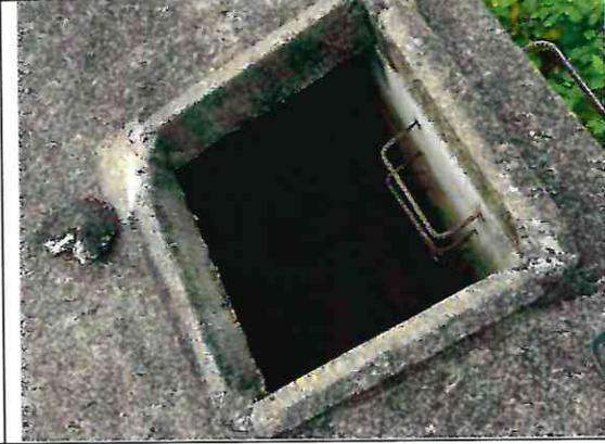
Tal y como se aprecia en las siguientes fotos, hay una falta de mantenimiento de las instalaciones, observando incluso deterioro del recubrimiento de algunas de las paredes del tanque de 2300 m<sup>3</sup>:
