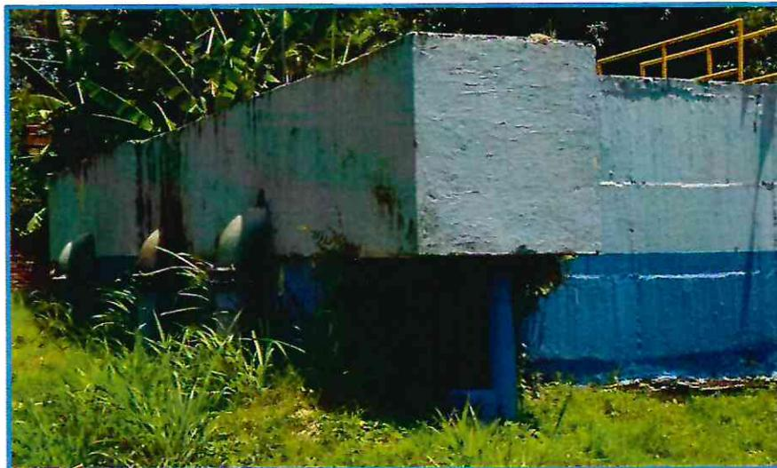
Ingreso al sistema en tubería de 10" que conduce agua cruda al pre-tratamiento: Desarenación.
