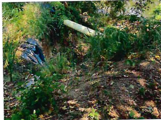
Laguna No 1, detalle de talud caído y tubería de Bypass a laguna No. 2
